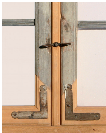
Fenêtre restaurée avec remplacement partiel des menuiseries. Les ferrements anciens ont été réutilisés. Photos : Hermann Klos.
