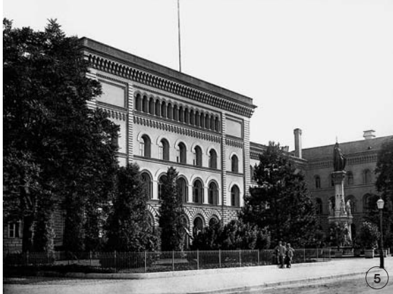
Palais fédéral Ouest, construit entre 1852 et 1857 par Friedrich Studer. Premier Palais fédéral. Style sobre à arcs en plein-cintre. Il abrite notamment le DFAE, le DFJP et la Chancellerie fédérale. Photo de 1895.
