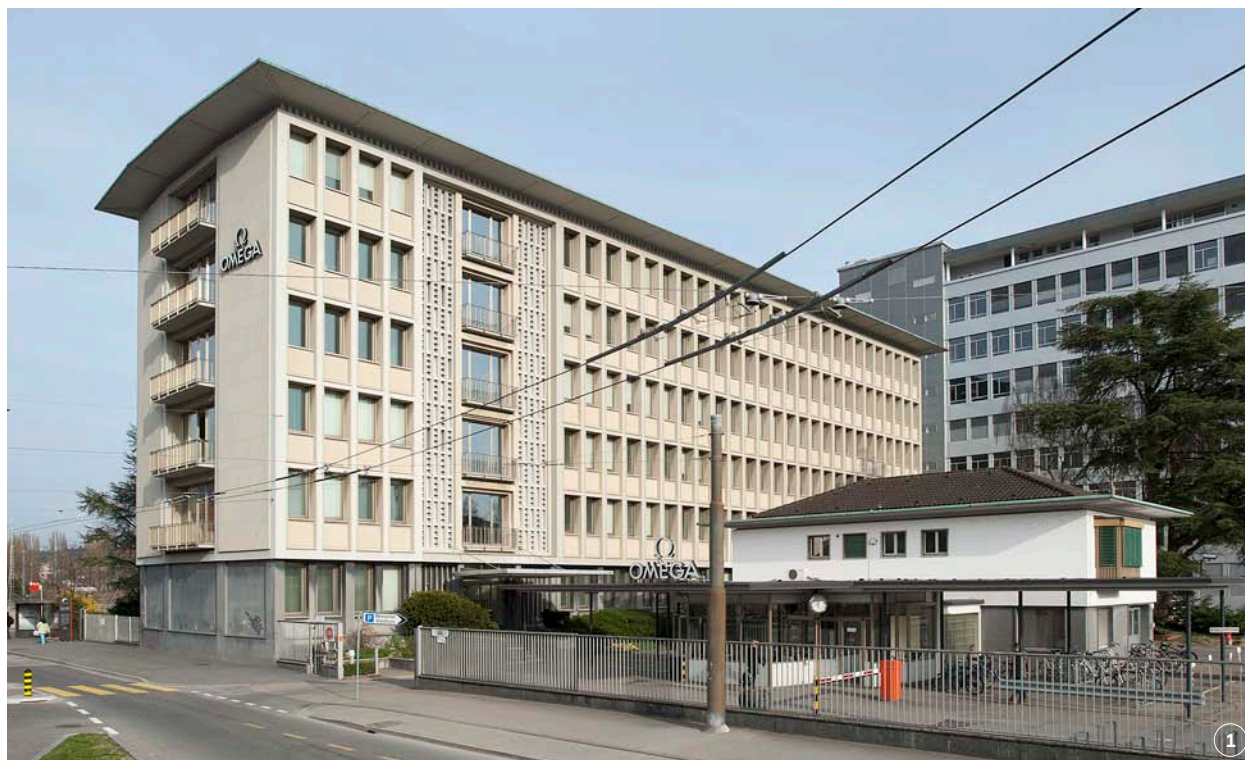
Bâtiment administratif OMEGA, Bienne, construit en 1955–1956 par l'architecte soleurois Oskar Sattler
