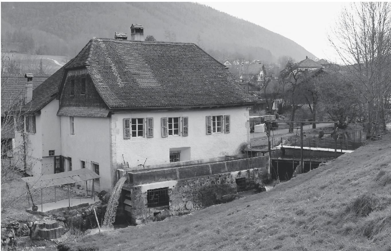
Le martinet avec sa roue à augets et le canal, alimentés par l'eau de la Gabiatte. Photo 2008 (GHZ).
