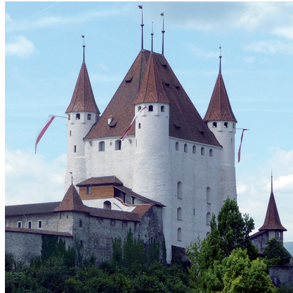
Bergfried Schloss Thun, Baubeginn um 1200
