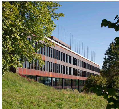
Hauptgebäude der Sportschule Magglingen, 1969/1970
