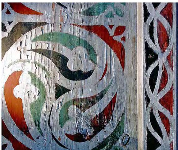
Evangelische Kirche Bergün, schadhafte Partie der gotischen Decke. Der Bereich befindet sich direkt oberhalb der Fensterbankheizung (Abb. 20)
