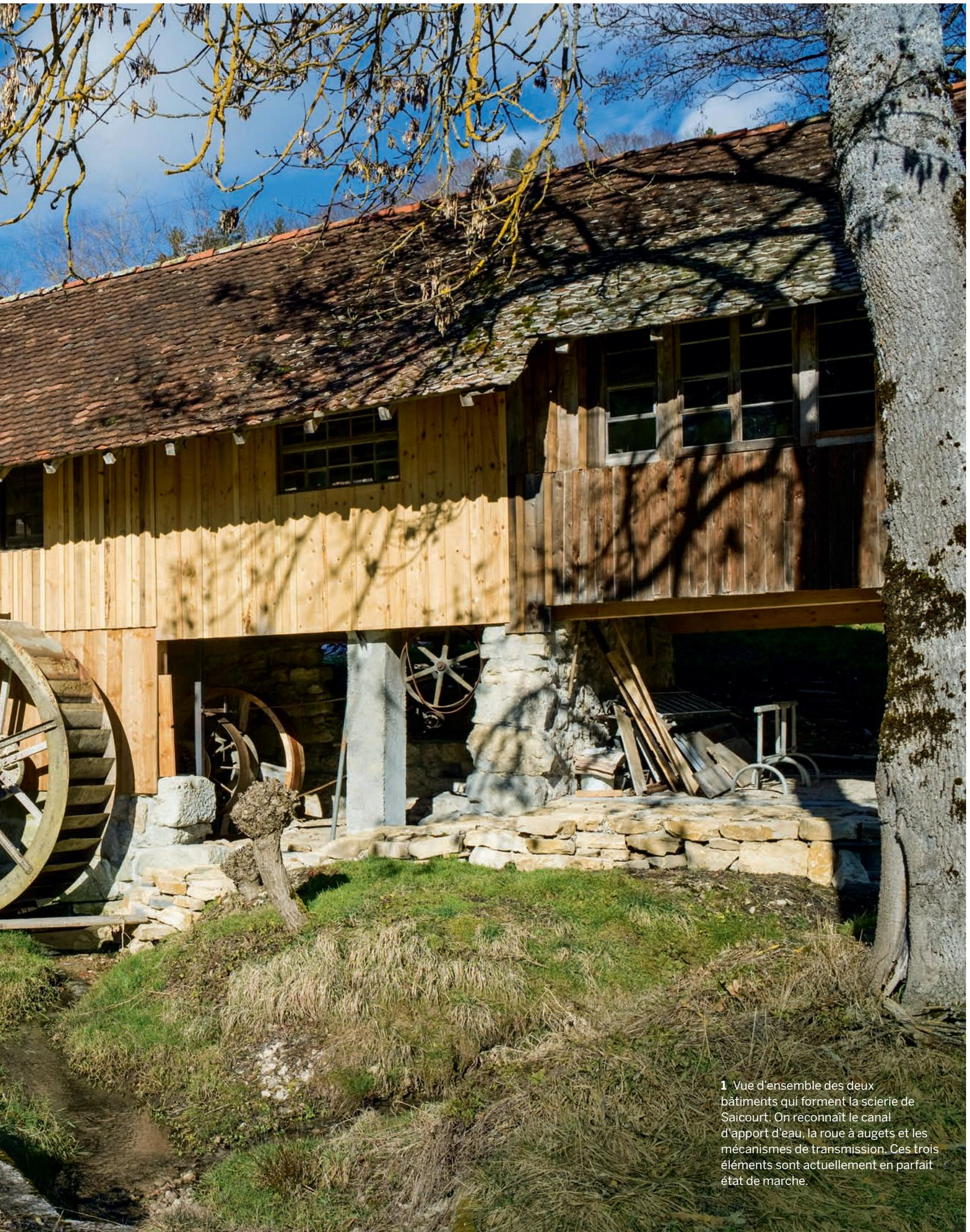
1 Vue d'ensemble des deux bâtiments qui forment la scierie de Saicourt. On reconnaît le canal d'apport d'eau, la roue à augets et les mécanismes de transmission. Ces trois éléments sont actuellement en parfait état de marche.
