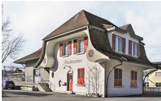
◀7 Das Bahnhofsgebäude Fraubrunnen von Karl Indermühle (1916). Fast identische Bahnhofsgebäude stehen, zumeist ordentlich restauriert, noch heute in Schönbühl, Jegenstorf oder Grafenried. Von einem grösseren Typus ist einzig jenes in Bätterkinden.
