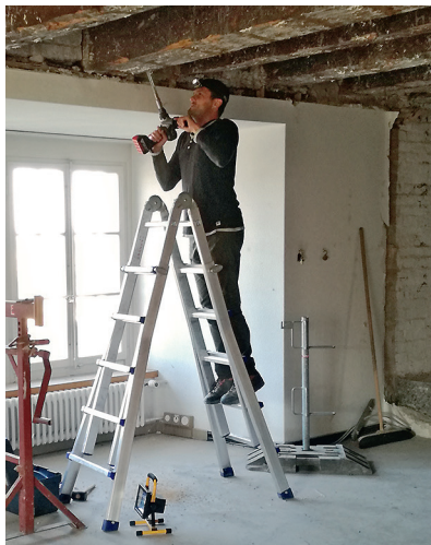
Entnahme einer Holzprobe im Schloss Burgdorf. Die Bäume für die massiven Deckenbalken aus Fichte und Weisstanne wurden im Jahr 1200 n. Chr. gefällt, verarbeitet und wohl kurz darauf verbaut.
