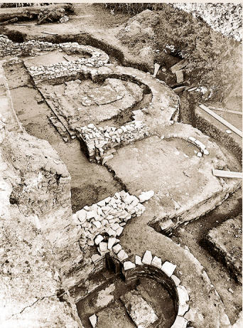
Vue vers le nord-ouest des absides dégagées lors des travaux de 1940.
