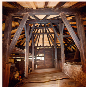
Der bemerkenswerte stehende Dachstuhl des 16. Jahrhun- derts kommt dank dem neuen Unterdach aus rohen Brettern gut zur Geltung. Blick nach Süden von der Heubühne aus.
