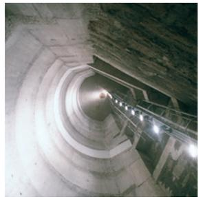
Durchs Panzerglas fällt der Blick in den Sanierungs-schacht. Weiss bemalt die Fundschicht und der sanierte Riss.
