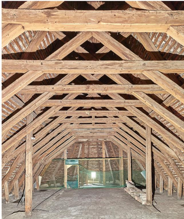
Das Dach über dem Chor wurde nur zehn Jahre nach der Schenkung des Bauplatzes aufgerichtet. Ende des 14. Jahrhunderts waren, möglicherweise aufgrund grösserer Schneelast wegen klimatischer Verschlechterung oder einer Neueindeckung mit Ziegeln, Verstärkungen erforderlich. Blick nach Osten.
