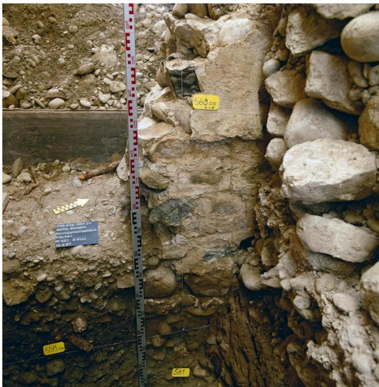
Abb. 42: Bern, Bümpliz-Kirche. 1997. Zone A. Die Ostfront von M501 zeigt, wie über der alten Fugenstrichmauer später ein Verputz angebracht wurde. Die Unterkante liegt bis knapp unter 560 müM. (1997.01,52).
