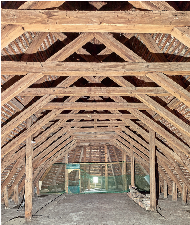
Das Dach über dem Chor wurde nur zehn Jahre nach der Schenkung des Bauplatzes aufgerichtet. Ende des 14. Jahrhunderts waren, möglicherweise aufgrund grösserer Schneelast wegen klimatischer Verschlechterung oder einer Neueindeckung mit Ziegeln, Verstärkungen erforderlich. Blick nach Osten.
